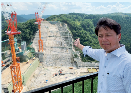
川上ダムの施工現場 ▶
